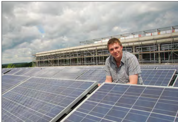
Zeit zum Strahlen: Martin Semmeling von der Brunsch und Rippe GmbH aus Stuhr bei Bremen hat den Aufbau der 216 Solarmodule auf dem Dach der Sporthalle am Mühlenberg betreut.
