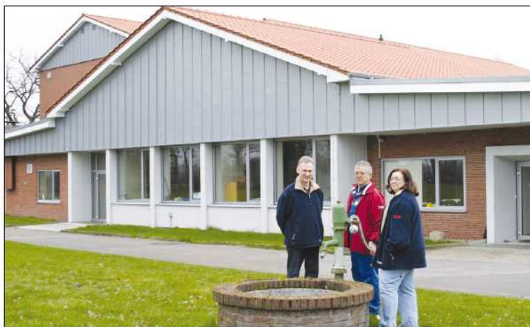
Uwe Fuhlendorf, Salvador Pesqueira und Astrid Oltersdorf freuen sich, dass ihr Wasserwerk endlich ein neues Dach bekommen hat.
